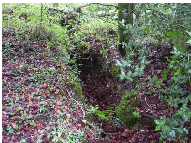
Tranchée non remblayée dans la zone boisée en pente
